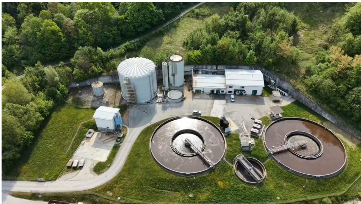
Slika 1: Čistilna naprava Laško
